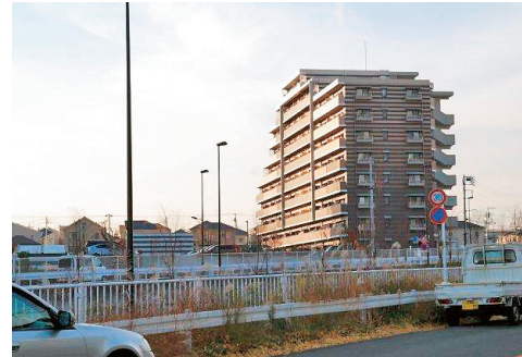
写真2：旧町田山崎団地(建替え後・2012年12月撮影)
