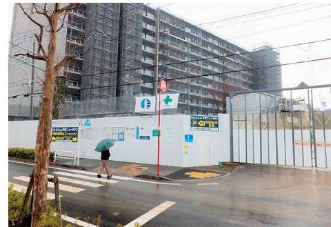
写真4：旧諏訪2丁目団地(建替え工事中・優良建築物等整備事業補助金あり・2013年2月撮影)
